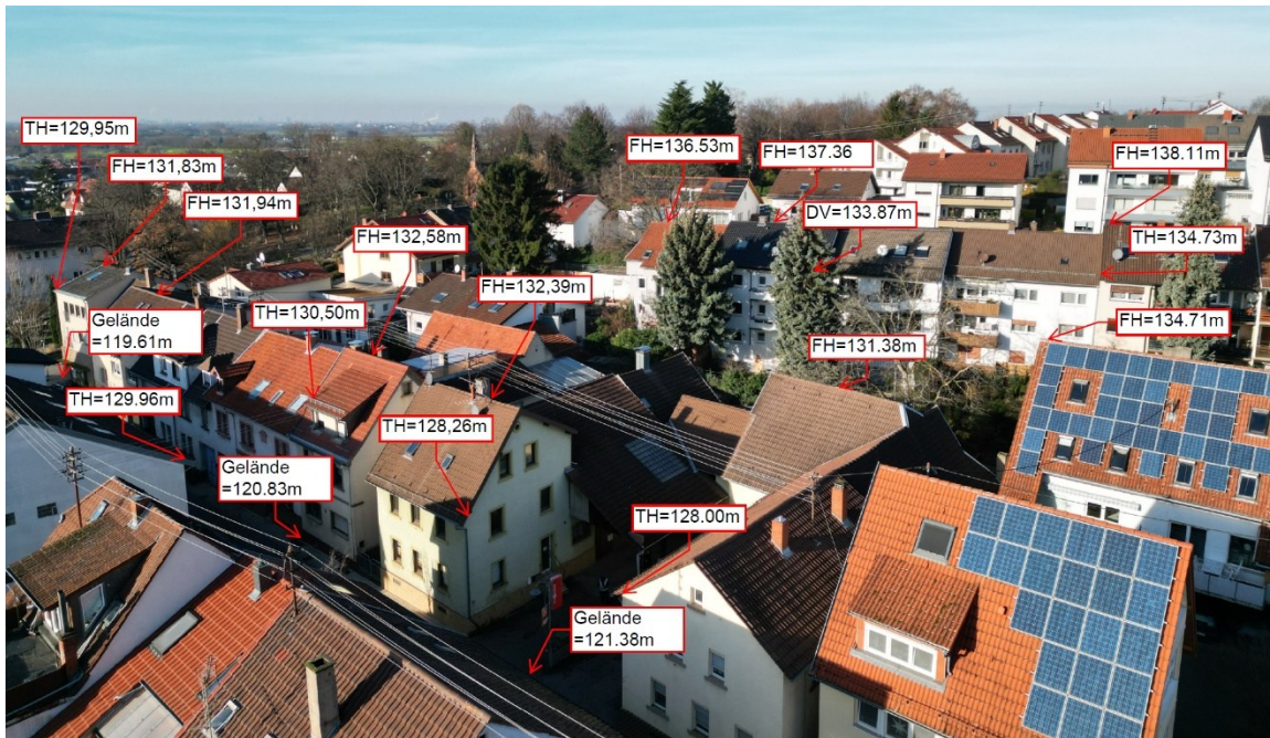
Drohnenfoto mit Gebäudehöhen aus Bestandsvermessung Ansicht von Südosten Bereich Hauptstraße 1 – 19 (links – rechts unten) + Reihenhausbauung südlich „Am Kronenburger Hof“ (Mitte - rechts oben) Quelle: Orani Gruppe, Stand 2024
